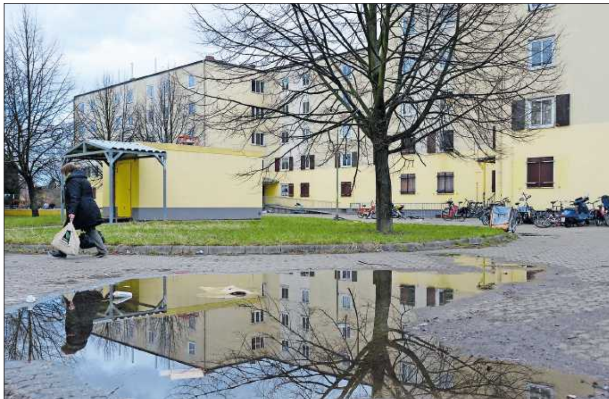
Sollen nun doch nicht abgerissen werden: die maroden Wohnblöcke in der Kropsburgstraße.
