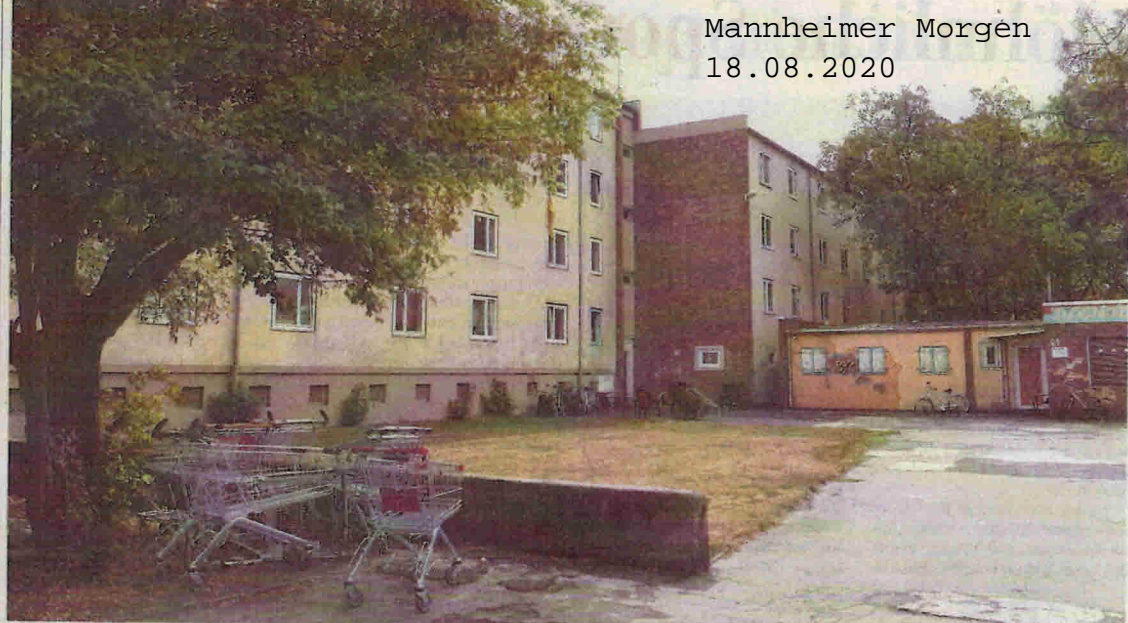
Die „roten Blöcke“ des Einweisungsgebiets für Wohnungslose in der Bayreuther Straße sollen abgerissen und neu gebaut werden.
