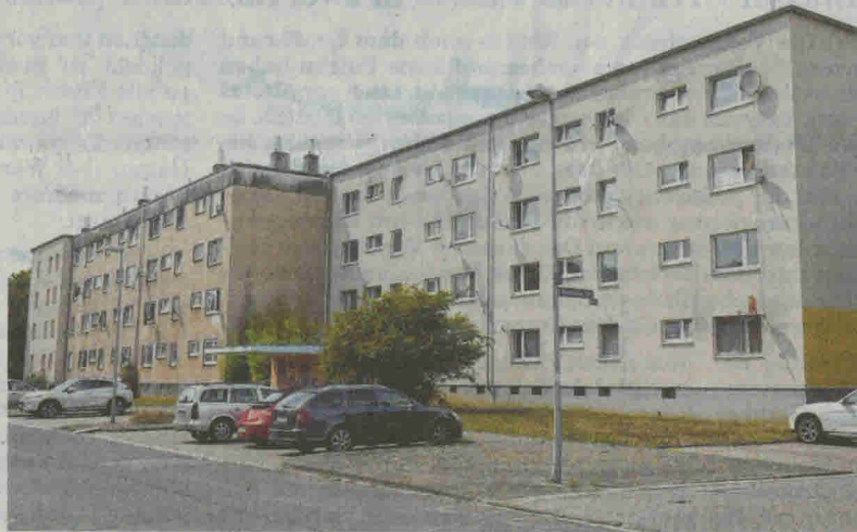
Die „Weißen Blöcke“ in der Bayreuther Straße werden umfassend saniert. Erst müssen aber die „Roten Blöcke“ abgerissen und neu gebaut werden.
