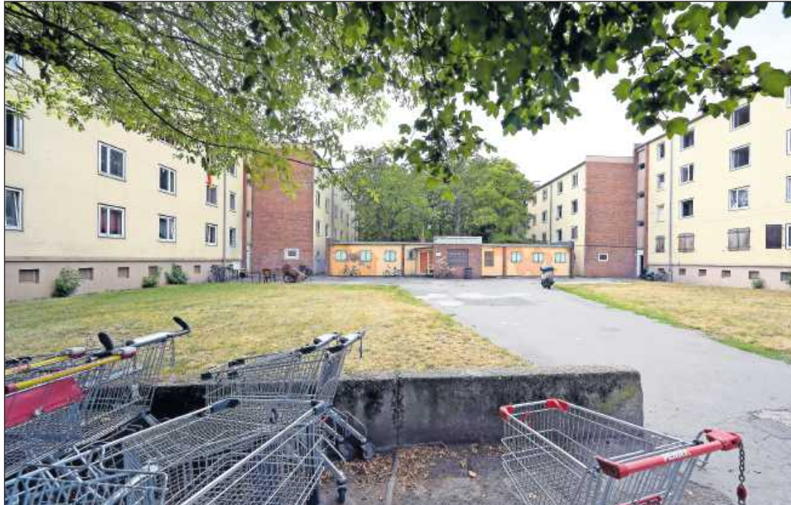
Bis sich in der Bayreuther Straße (im Bild) baulich etwas ändert, dauert es noch mehrere Jahre. Das Sozialkonzept ist unterdessen angelaufen.
