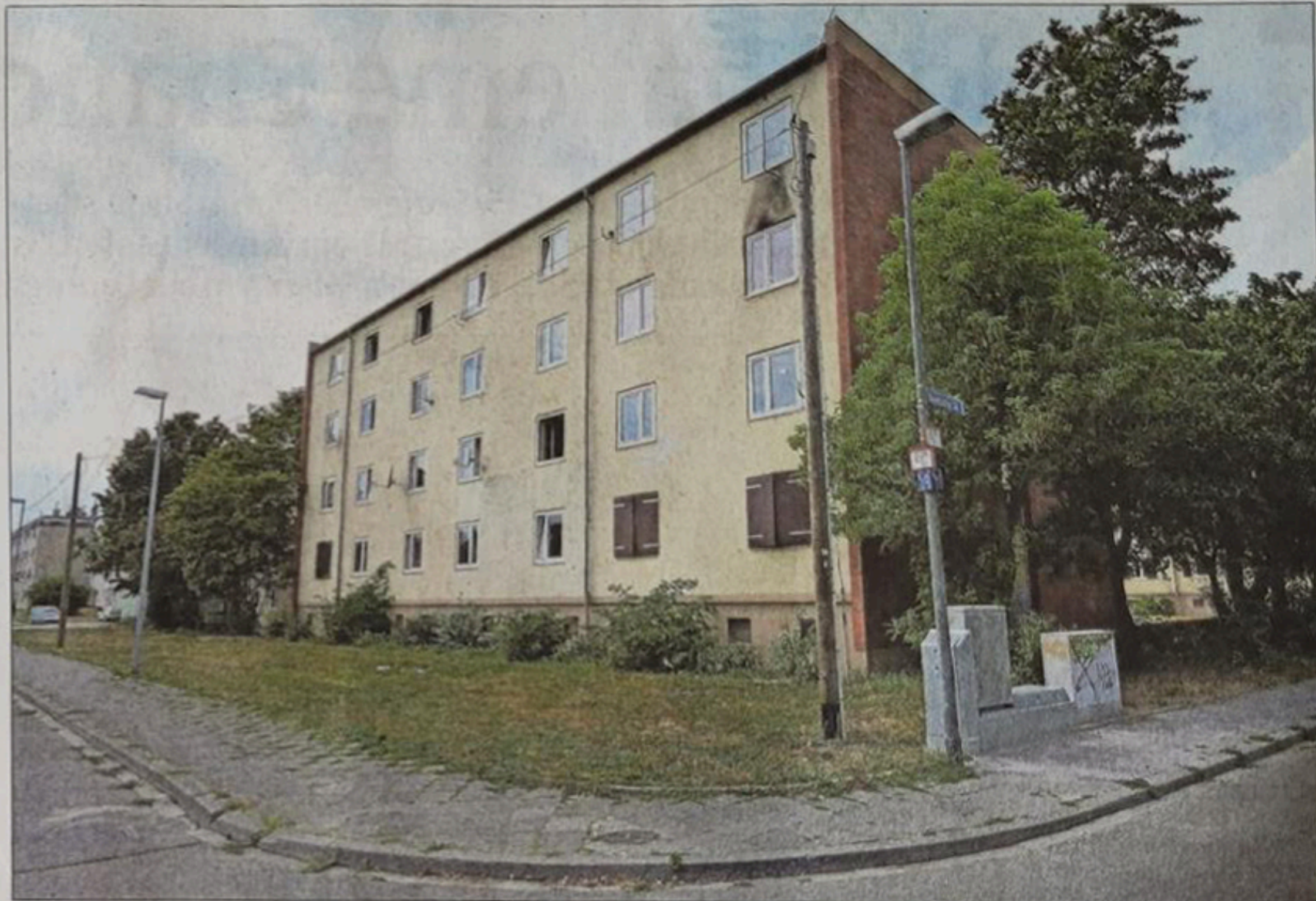
Die Ökumenische Fördergemeinschaft organisiert die Sozialarbeit in den Notwohngebieten in Mundenheim und West (im Bild die Bayreuther Straße).
